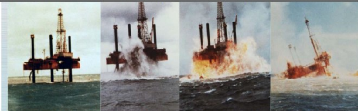
Гибель буровой платформы в результате выброса газа из газового кармана с АВПД и последующего пожара
