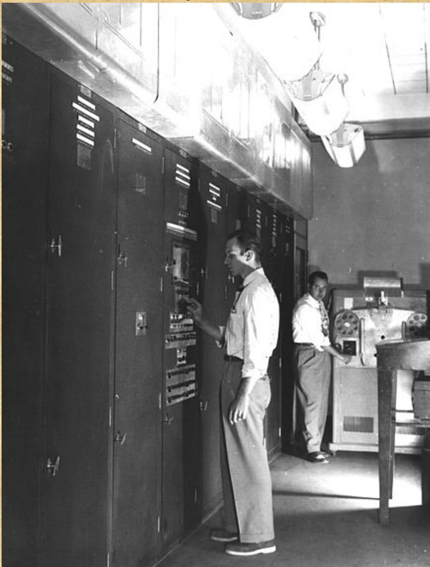
Компьютер состоял из 3563 электровакuumных ламп 19 различных типов, 8000 диодов, примерно 5500 конденсаторов, 12000 резисторов и потреблял 50 кВт энергии. Занимаемая площадь — 45,5 м<sup>2</sup>, масса — 7850 кг. Полный состав обслуживающего персонала — 30 человек на каждую 8-часовую смену.
